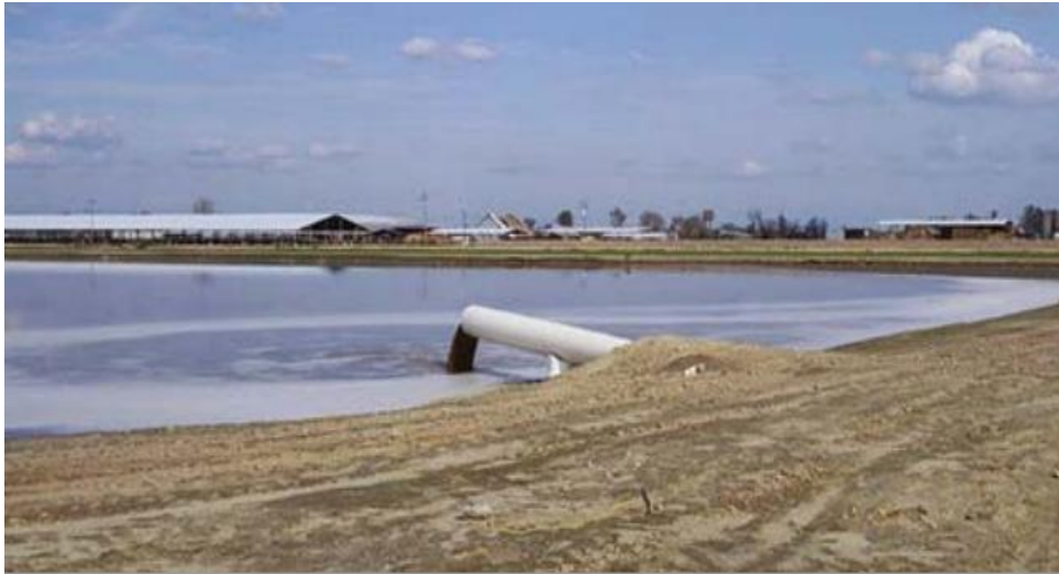
Рисунок 2 – Лагуна відкритого типу для зберігання відходів тваринництва
