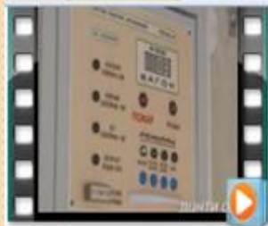
Пожежа в електропоїзді
